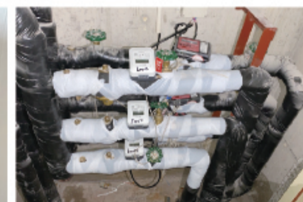
承德供热节能改造项目
