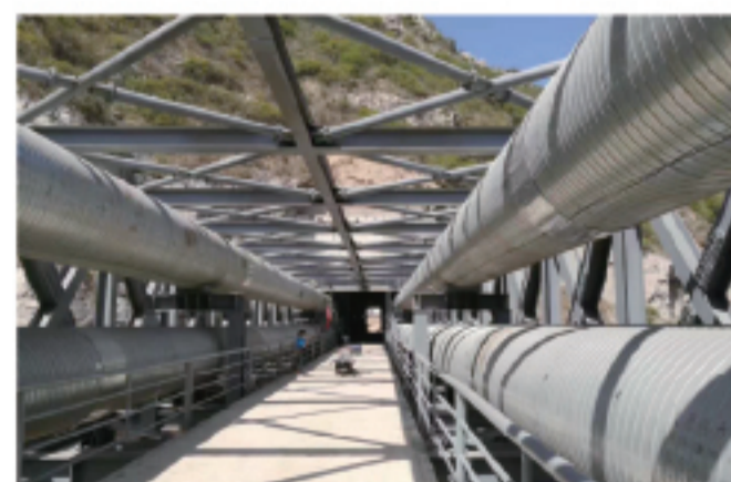
太古供热长输管网工程
