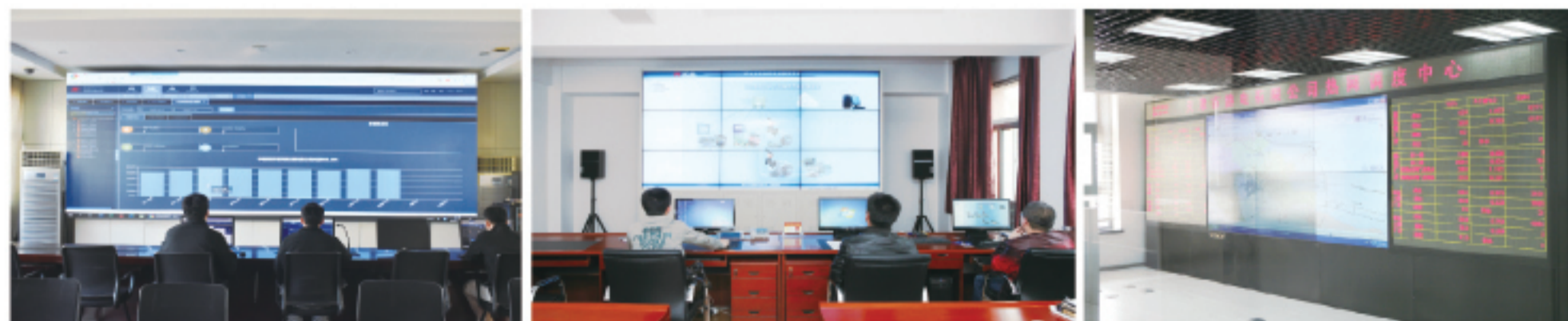
陕西某热力供热组网项目
